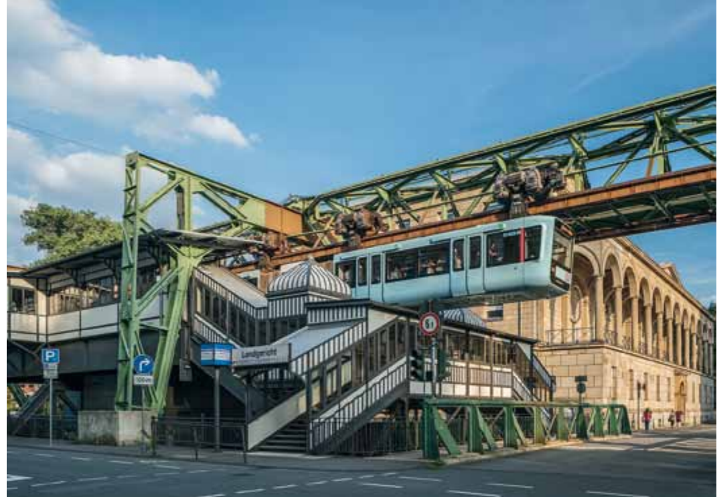
Schwebebahnstation Landgericht - Die Schwebebahnstation im Stadtteil Elberfeld südlich des Hardtberges wurde 1903 eröffnet und in den Jahren 2010/2011 originalgetreu im Jugendstil neugebaut. Architektonisch weist sie seitlich Kragdächer unterhalb der Tragkonstruktion zum Schutz der Bahnsteige auf. Die Gleise sind nicht überdacht. 1997 wurde sie in die Liste der Denkmäler der Stadt Wuppertal aufgenommen.
