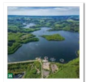
35 Rurtalsperre Schwammenauel - Luftbild
