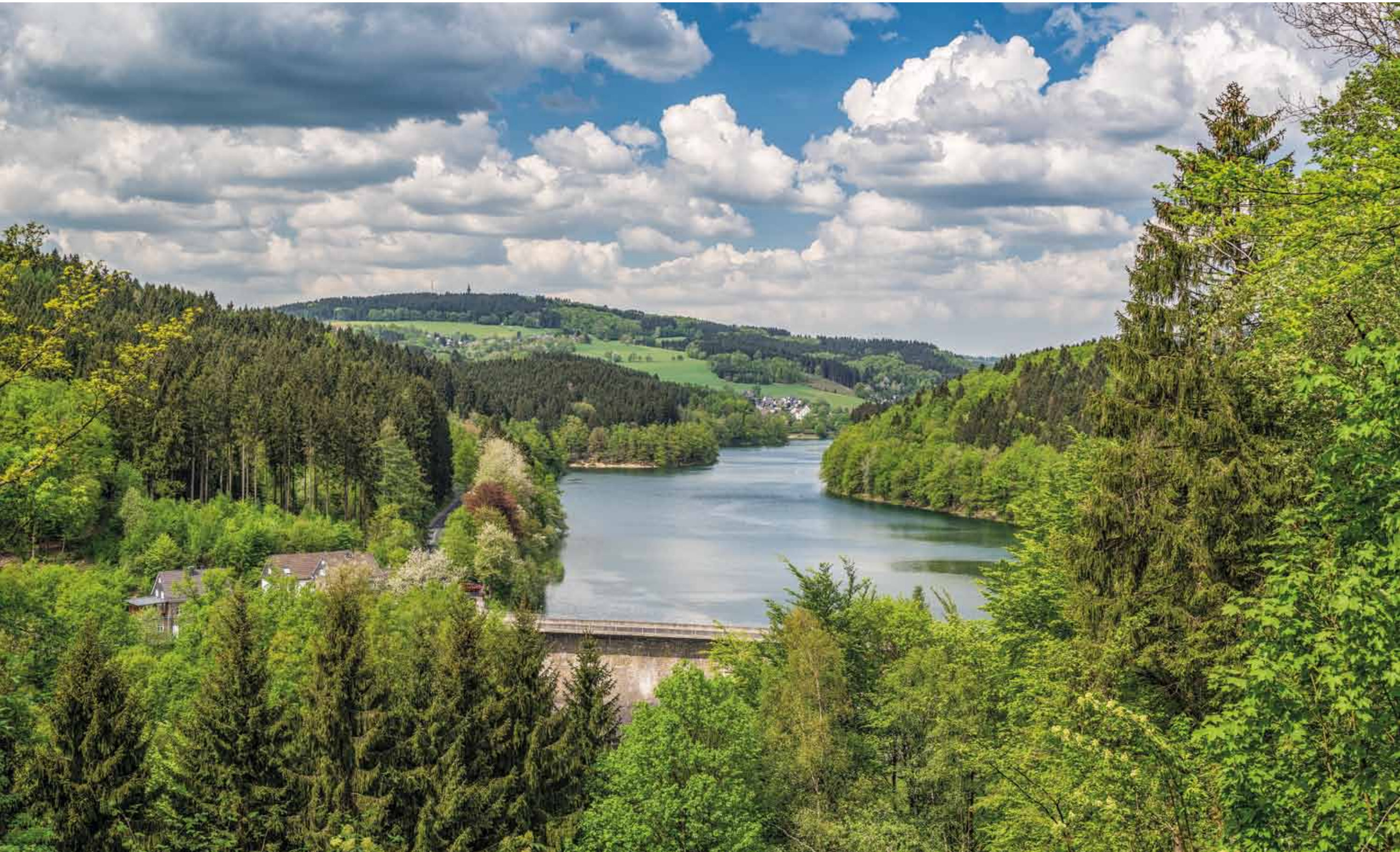
Aggertalsperre © Holger Klaes
