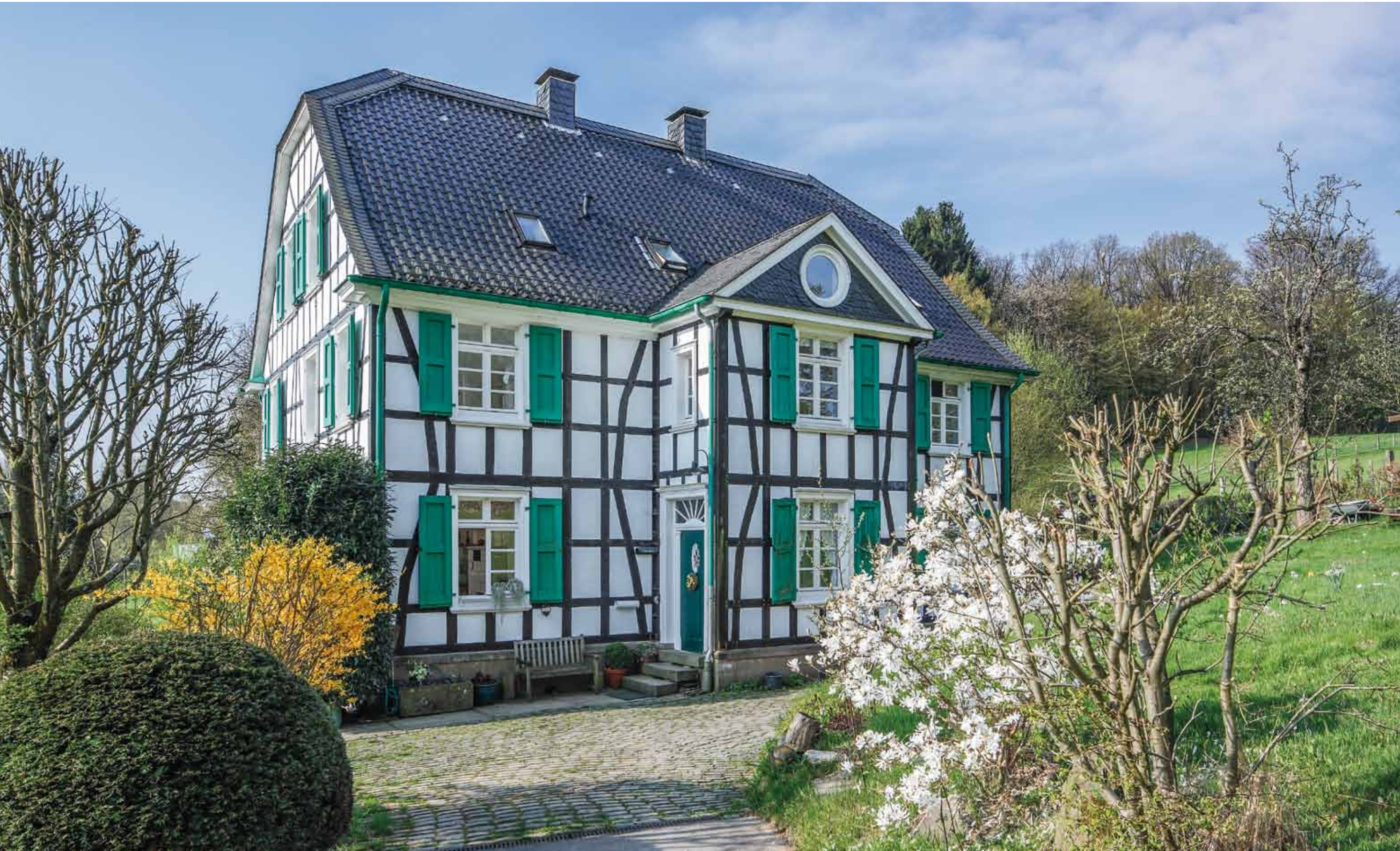
Ehemaliges Kontor und Wohngebäude des Tuchfabrikanten Lausberg in Dürhagen © Holger Klaes
