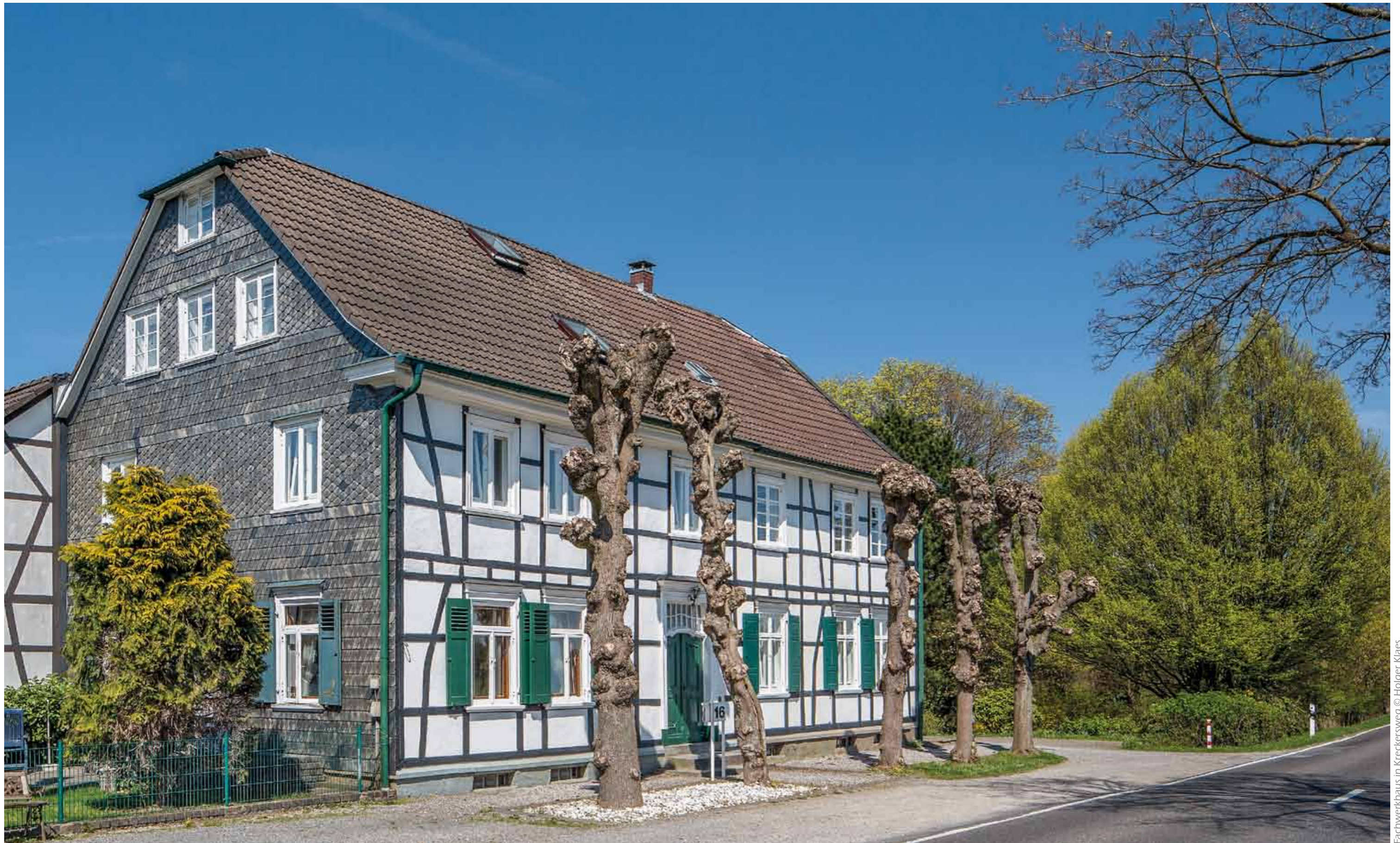
Fachwerkhaus in Kreckersweg © Holger Klaes
