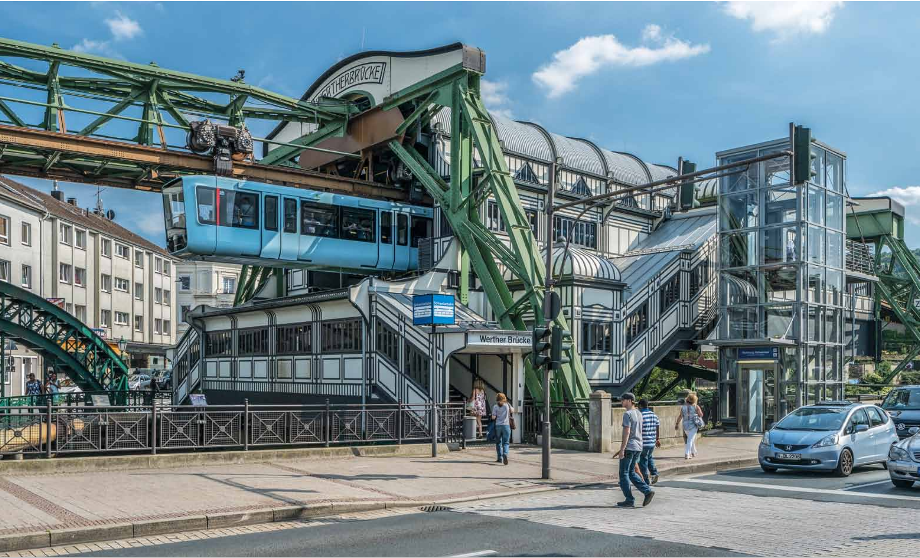
Station Werther Brücke in Barmen © Holger Klaes
