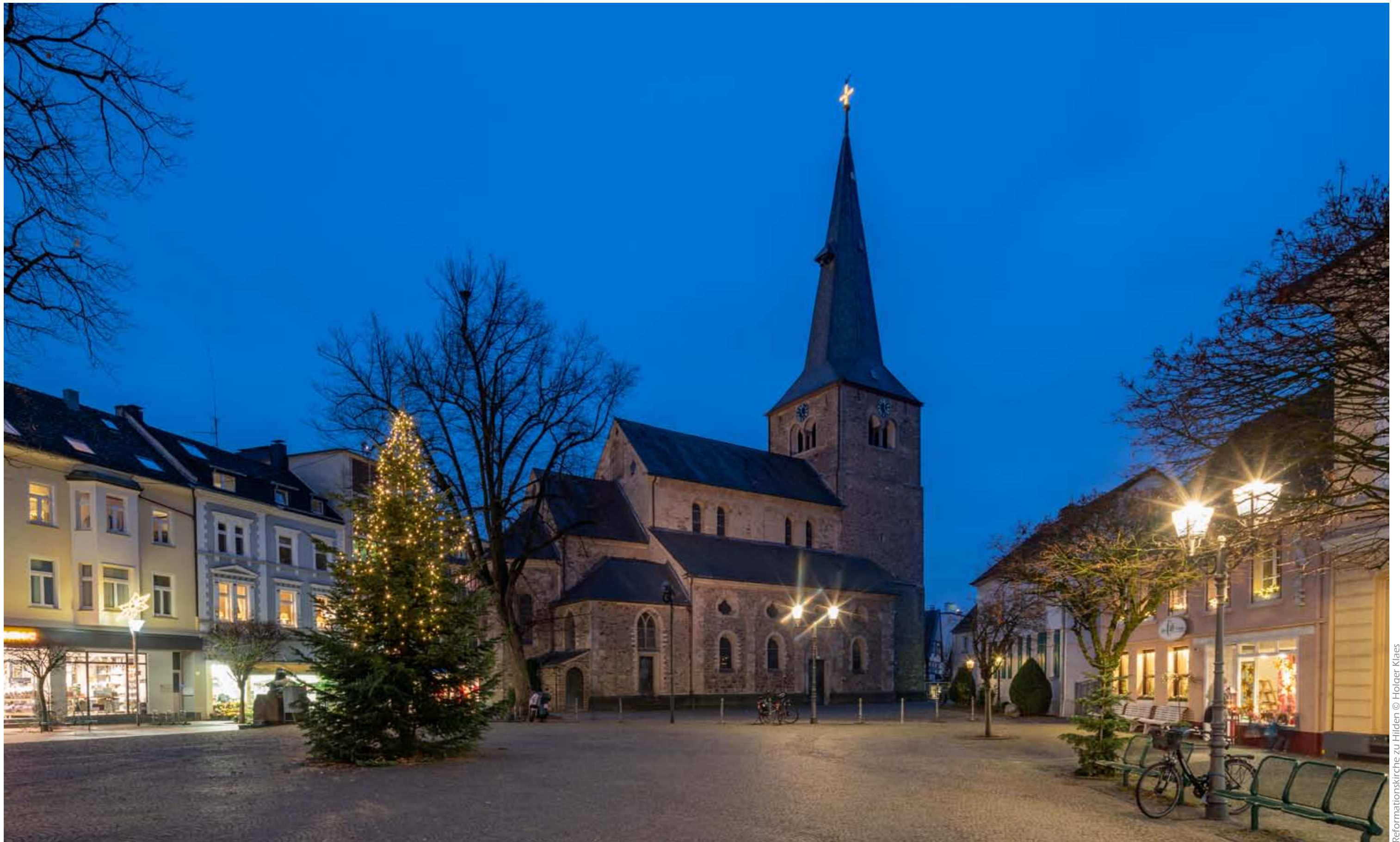
Reformatorenkirche zu Hilden © Holger Klaes
