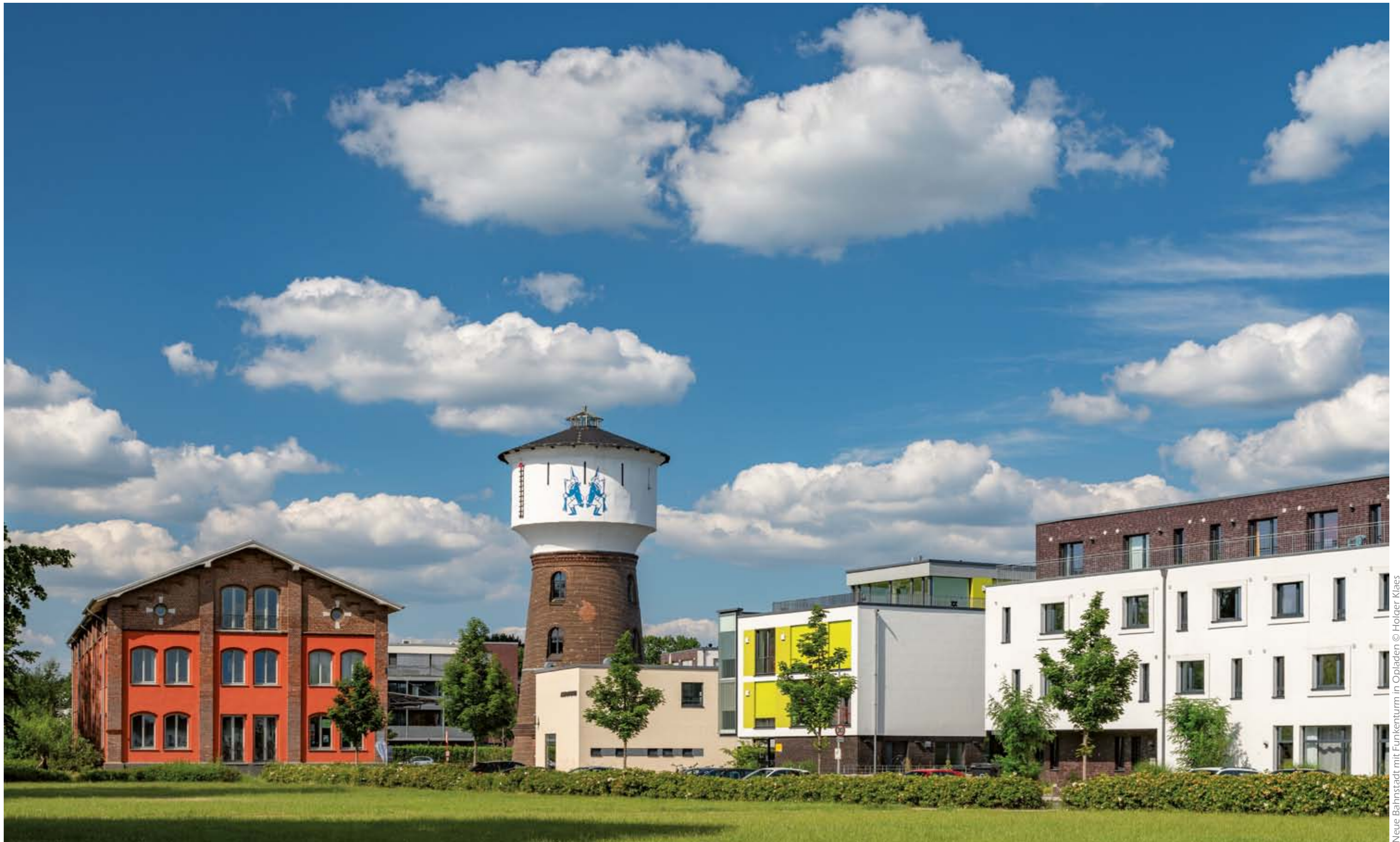
Neue Bahnstadt mit Funkenturm in Opladen © Holger Klaes
