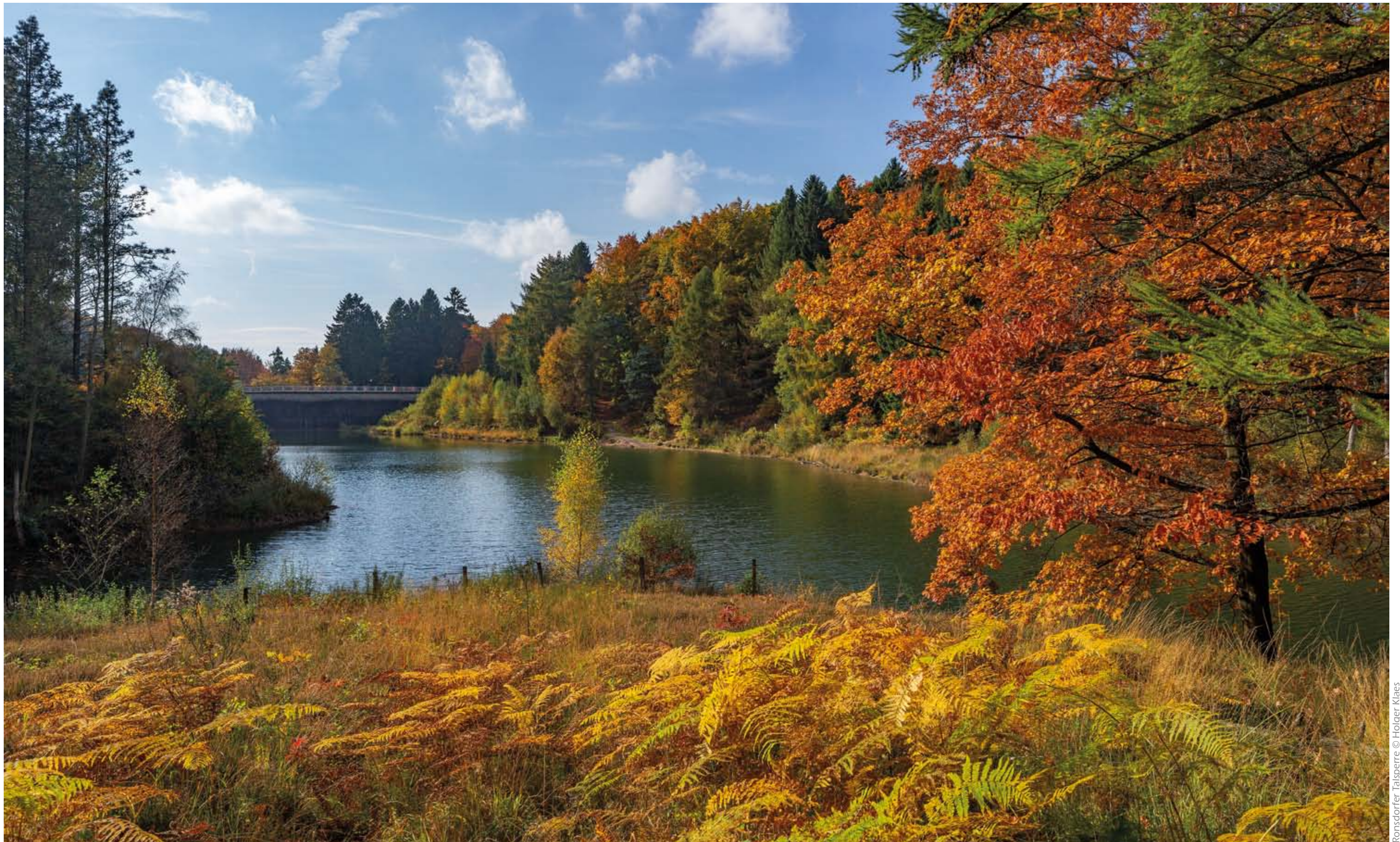
Romsdorfer Talsperre © Holger Klaes
