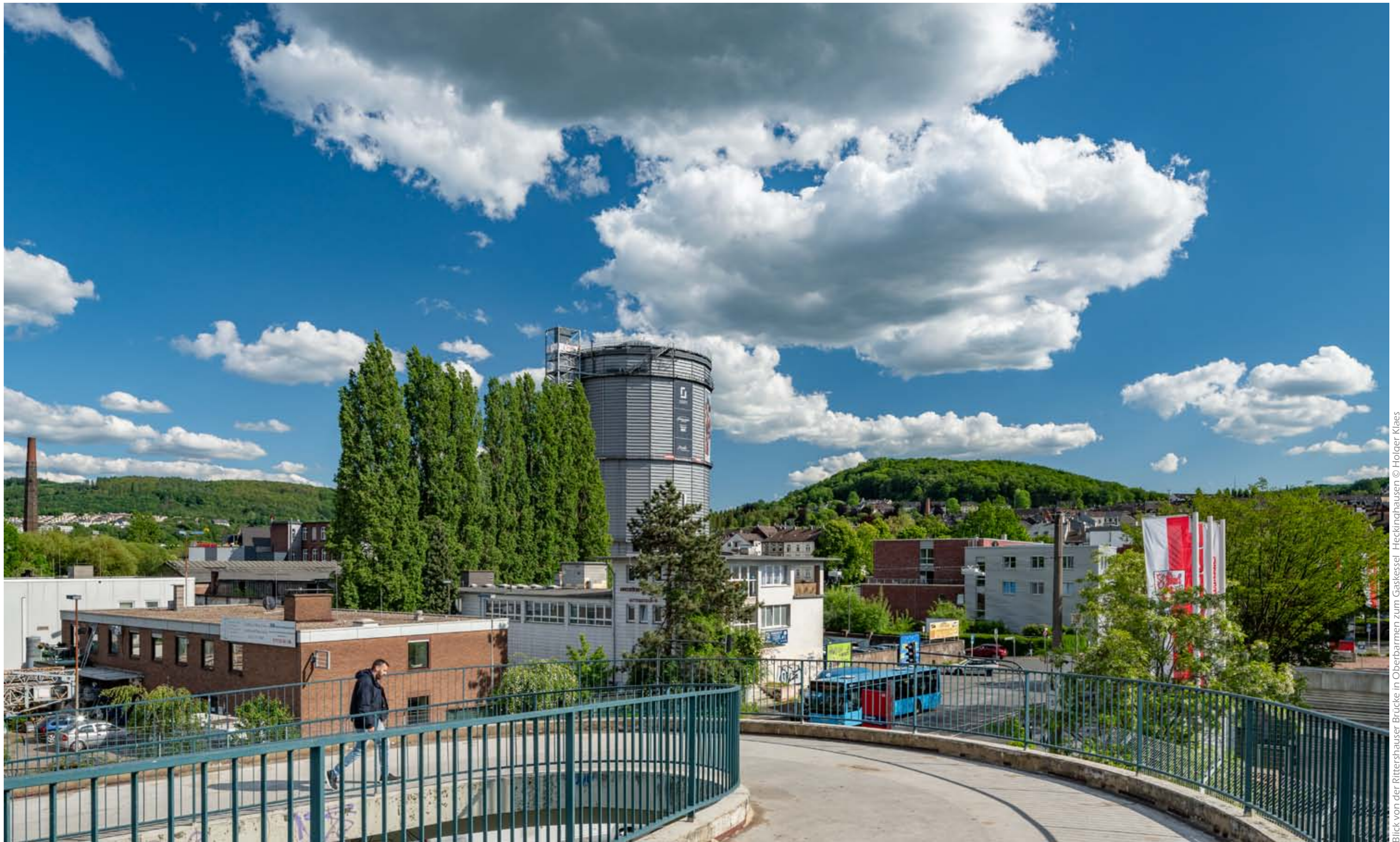
Blick von der Rittershäuser Brücke in Oberbarmen zum Gaskessel. Heckinghausen © Holger Klaes
