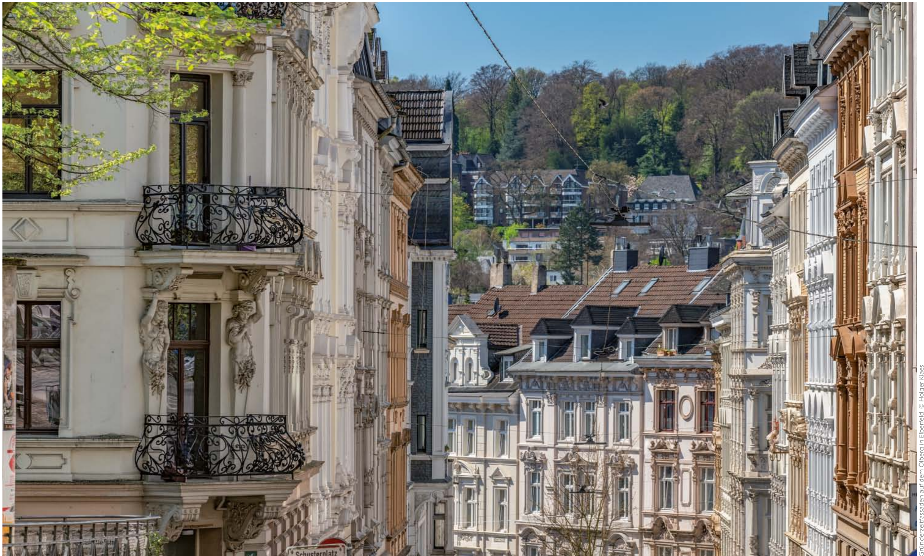
Gründerzeitfassaden auf dem Ölberg in Eiberfeld © Holger Klies
