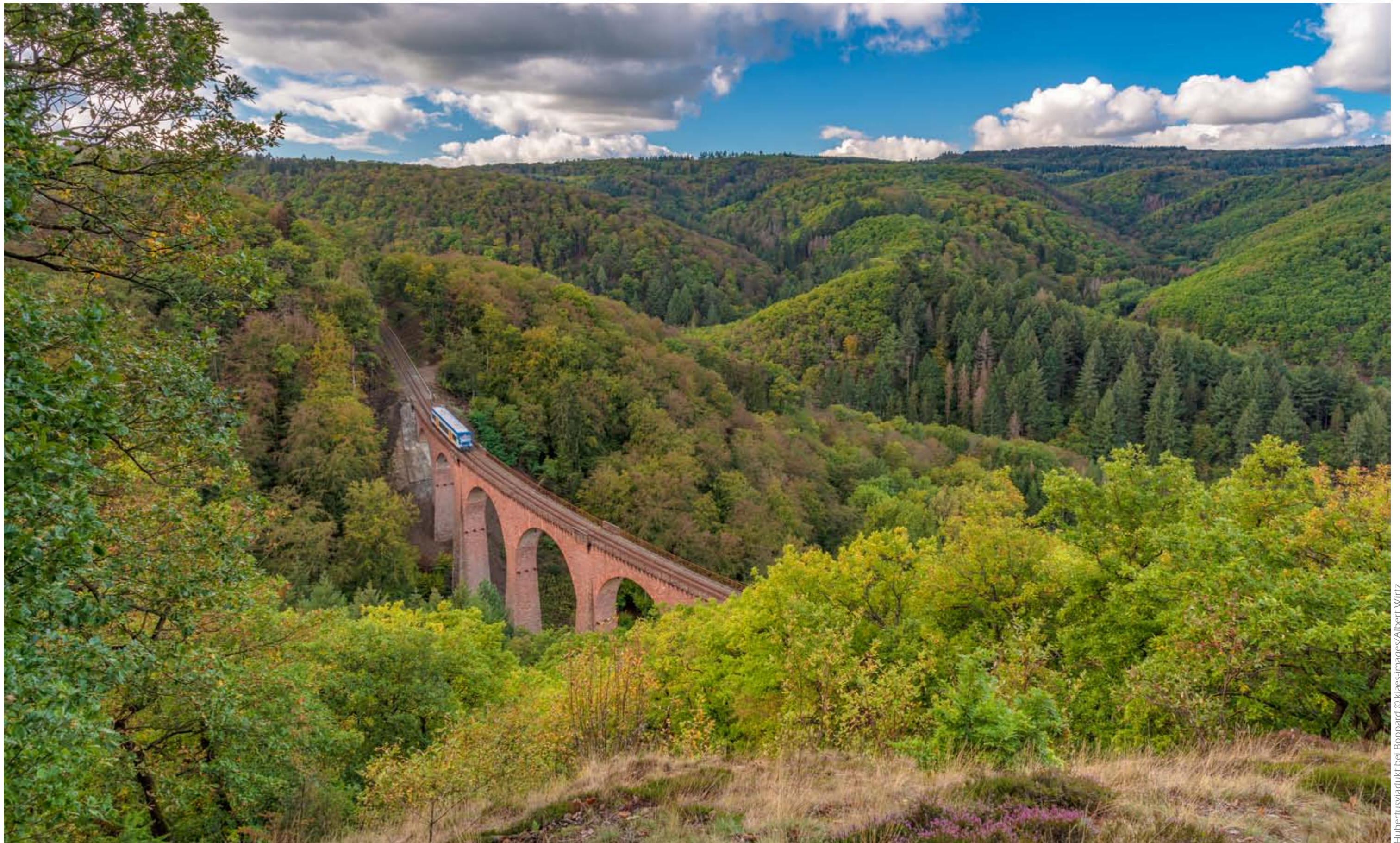
Hubertusviadukt bei Boppard © klaes-images/Albert Wirtz
