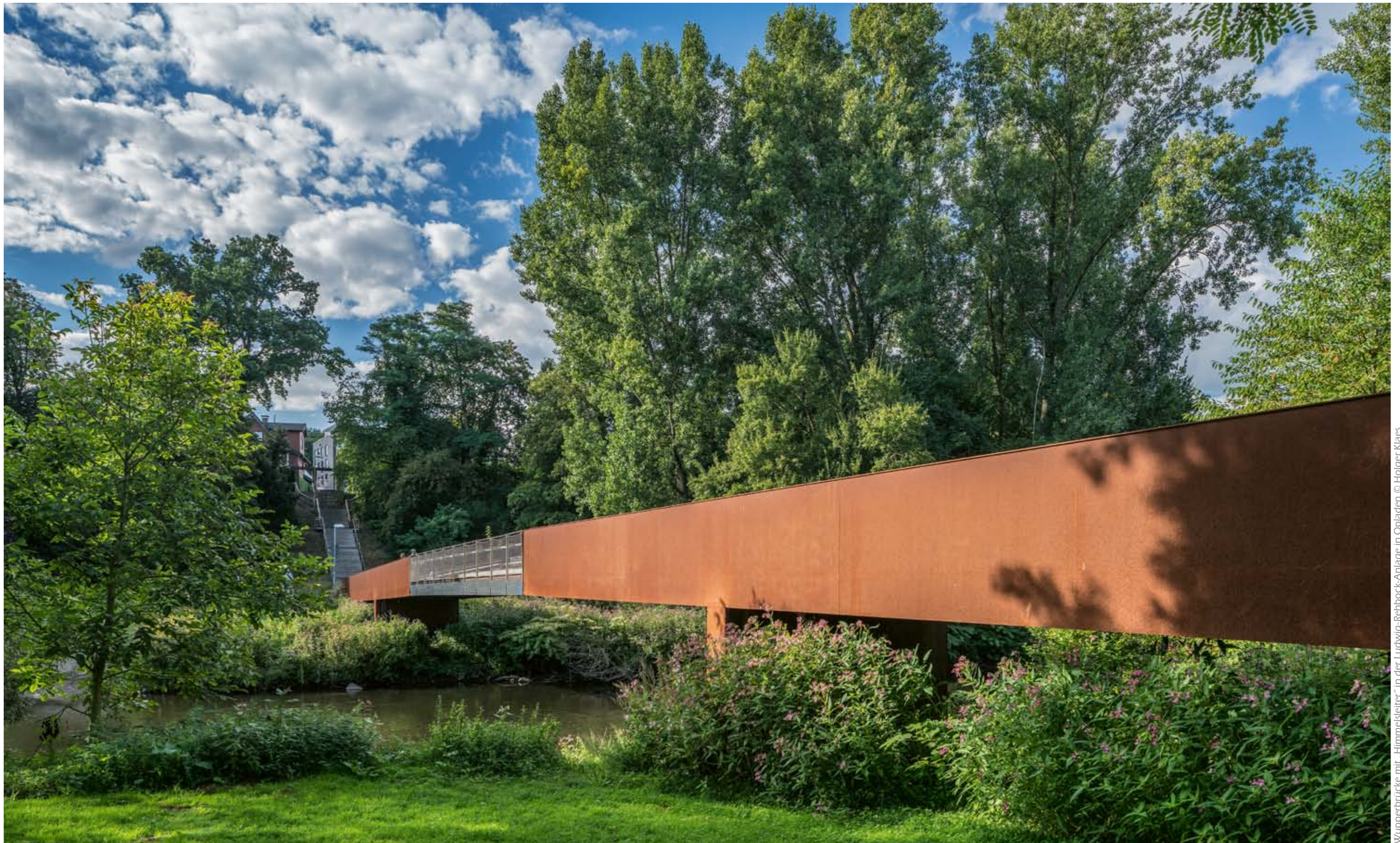
Wupperbrücke mit „Himmelseiter“ in der Ludwig-Rehbock-Anlage in Opladen © Holger Klaes
