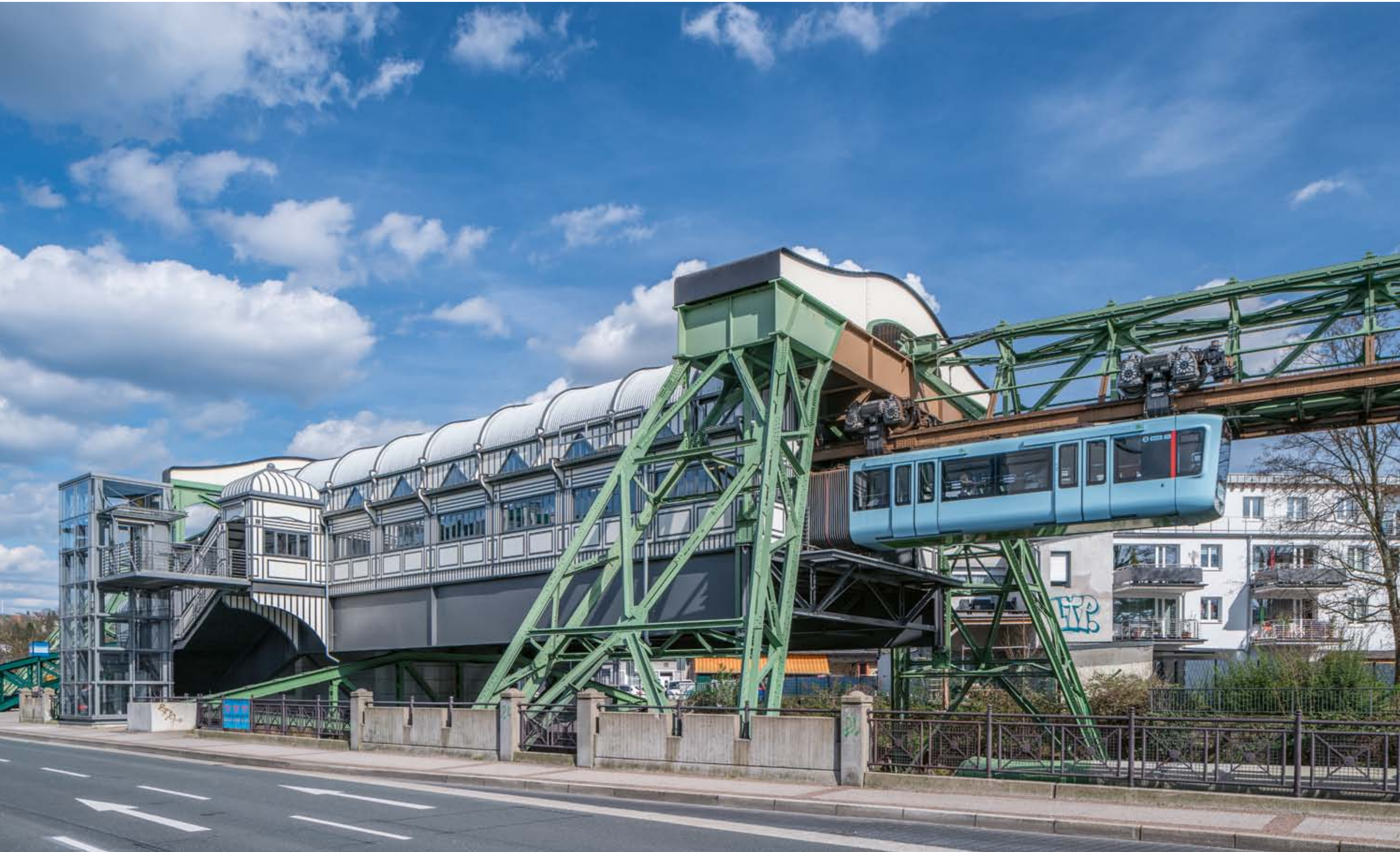
Station Werther Brücke in Barmen © Holger Klaes
