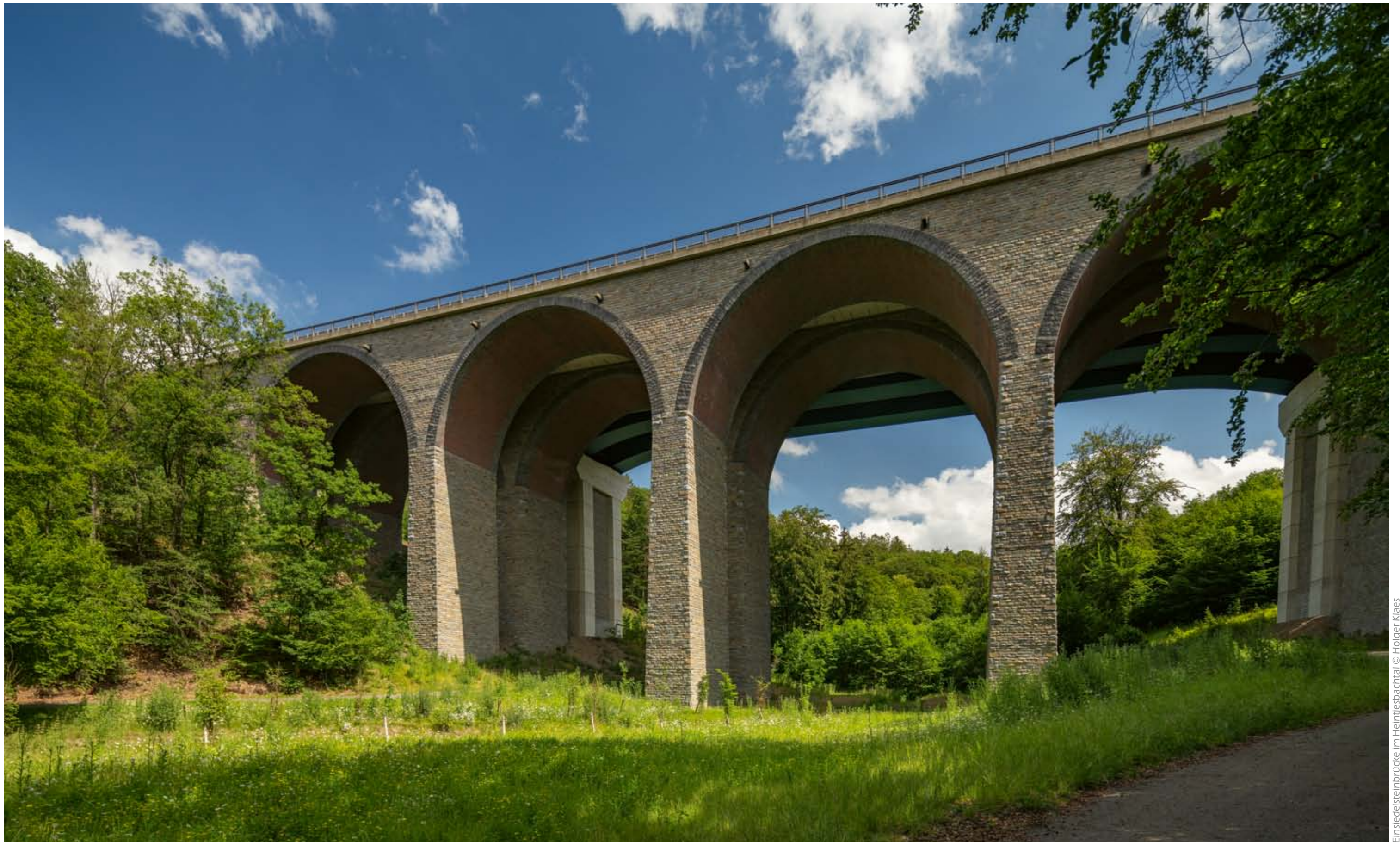
Einsiedelsteinbrücke im Heintjesbachtal © Holger Klaes
