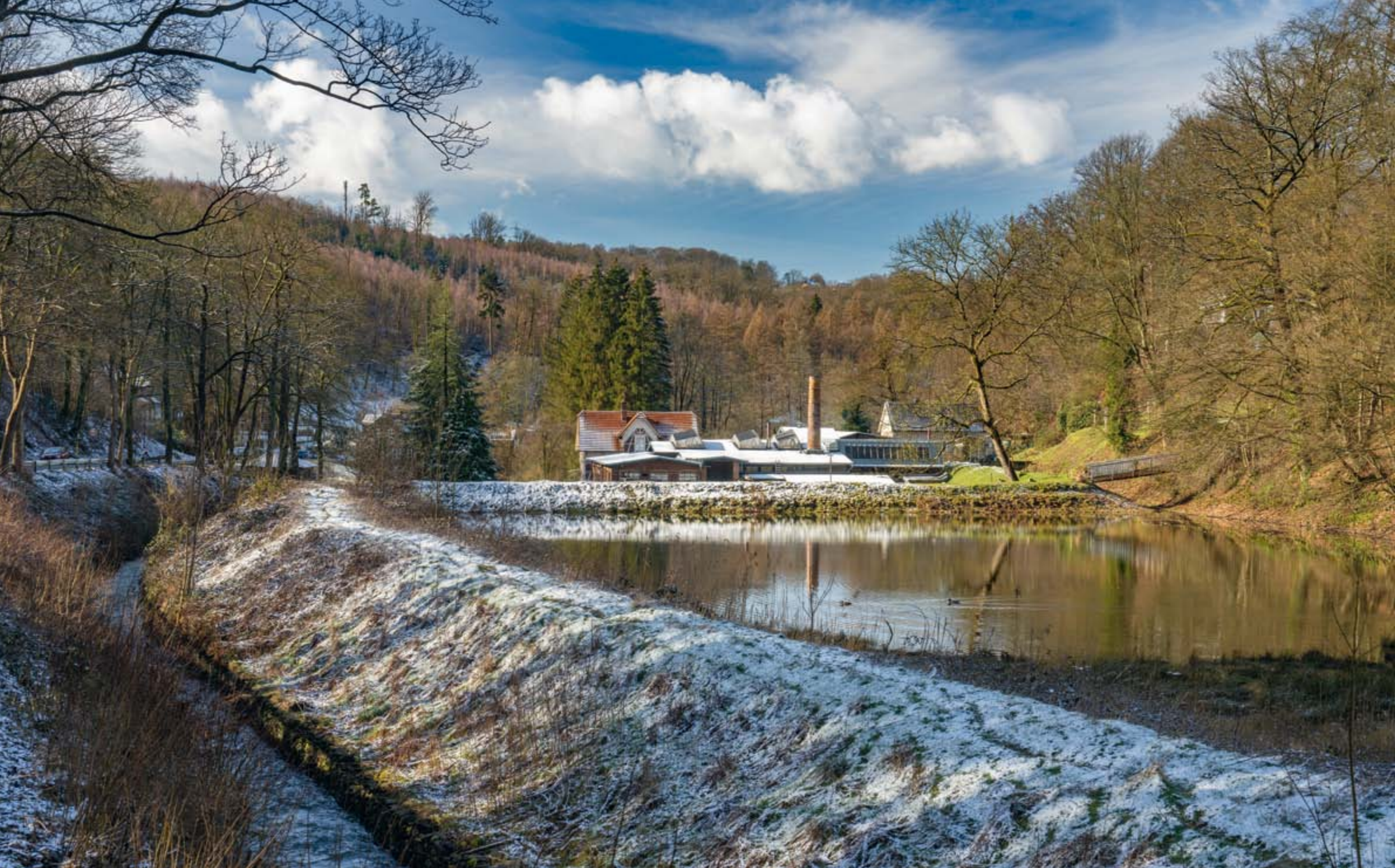
Remscheid - Ehemalige Feilenfabrik Ehlis in Schlepenpohl © Holger Klaes
