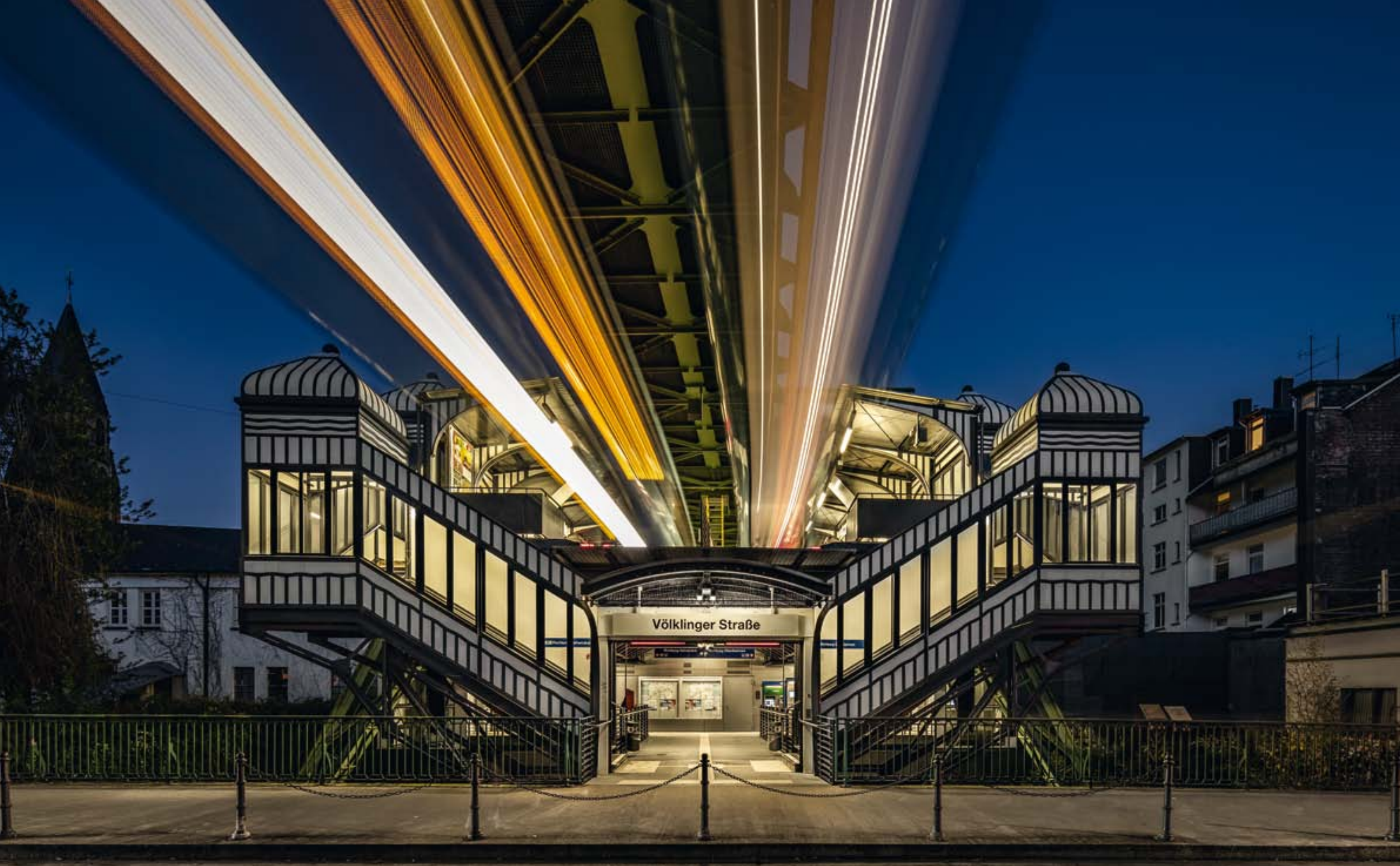
Wuppertaler Schwebebahn - Station Völklinger Straße © klaes-images/Frank Laumen
