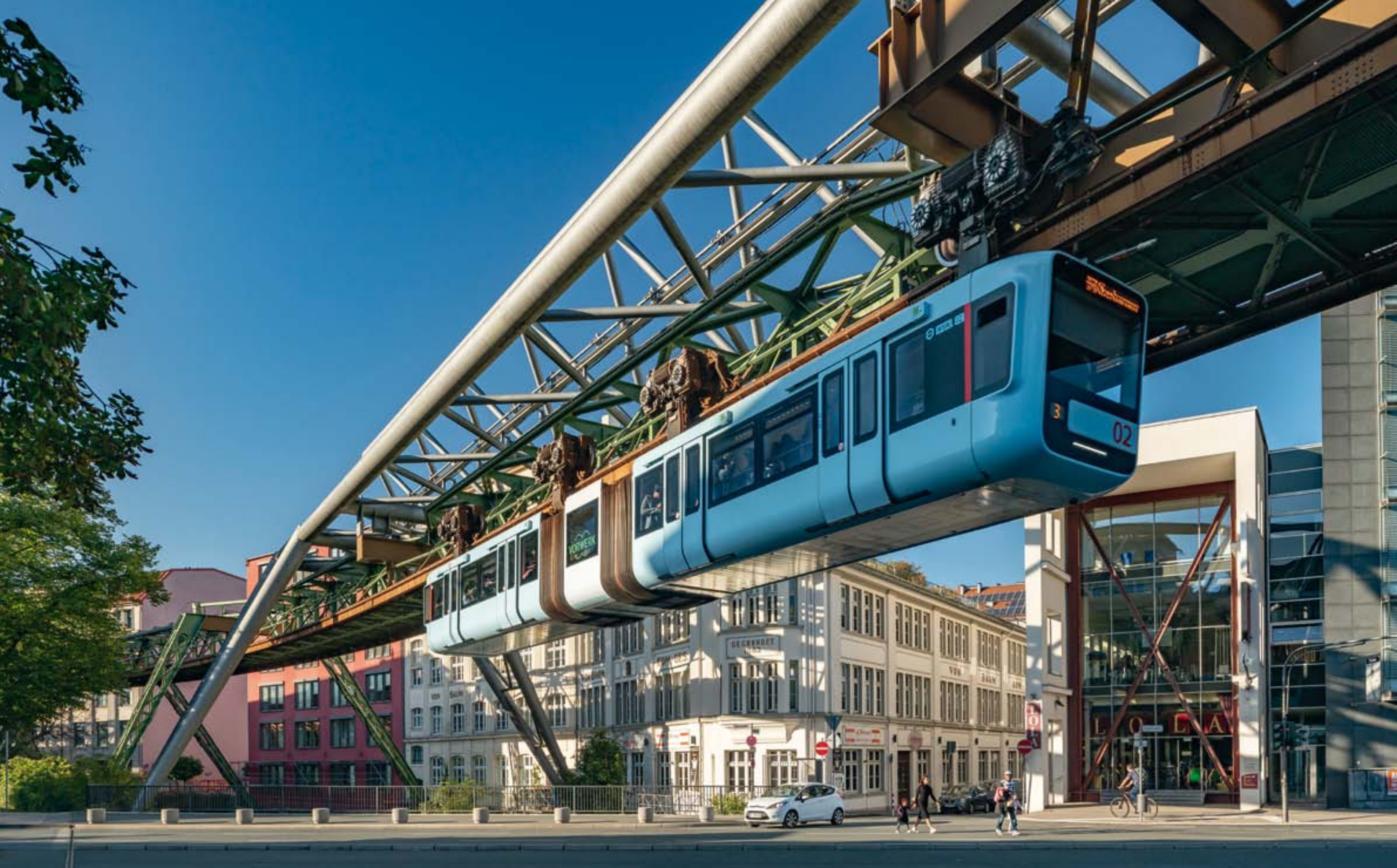
Wuppertaler Schwebebahn - Schwebebahnüberbau an der B7 vor dem Gebäudeenseble Baumsche Fabrik © Holger Klaes
