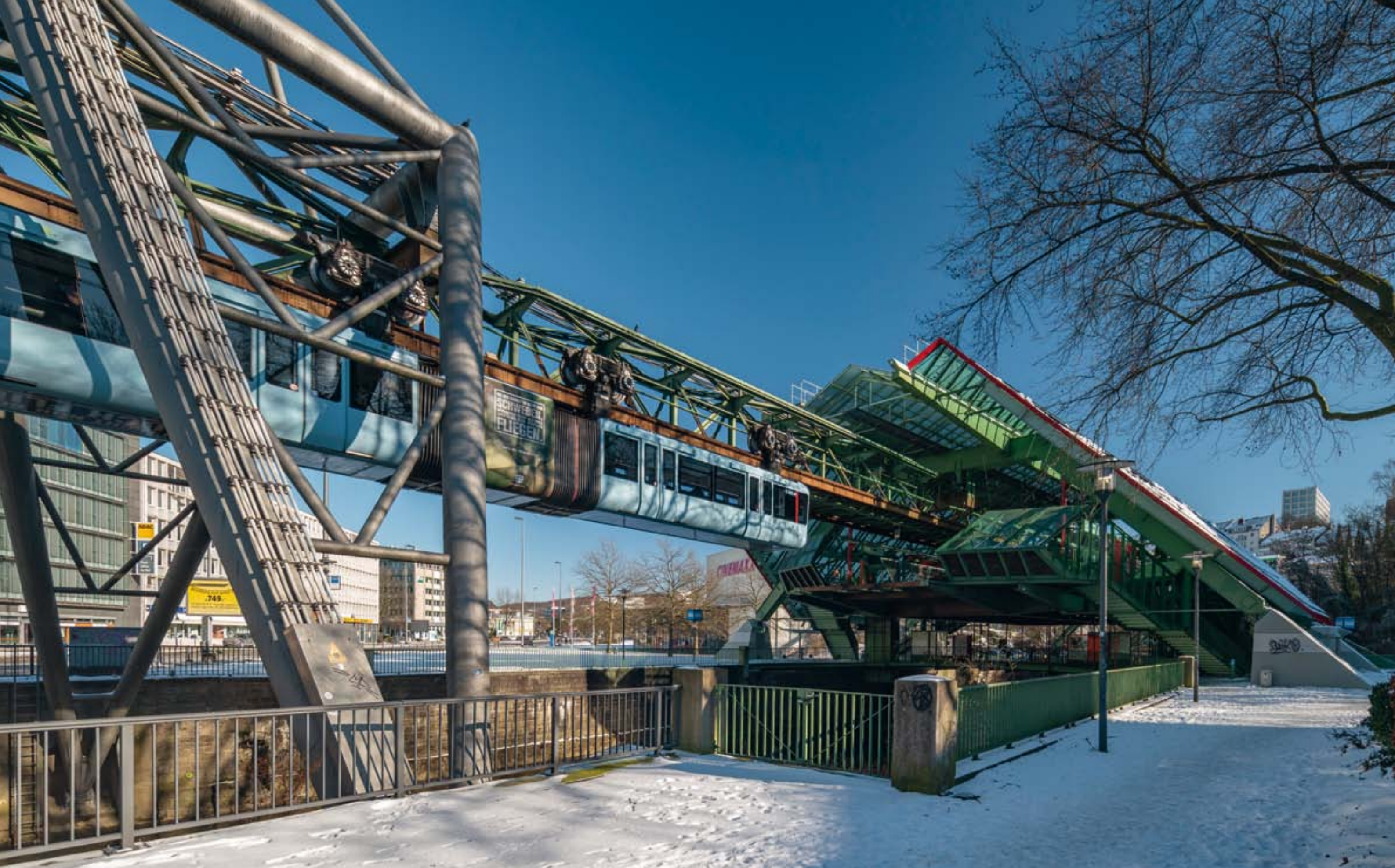
Wuppertaler Schwebebahn - Station Kluse © Holger Klaes
