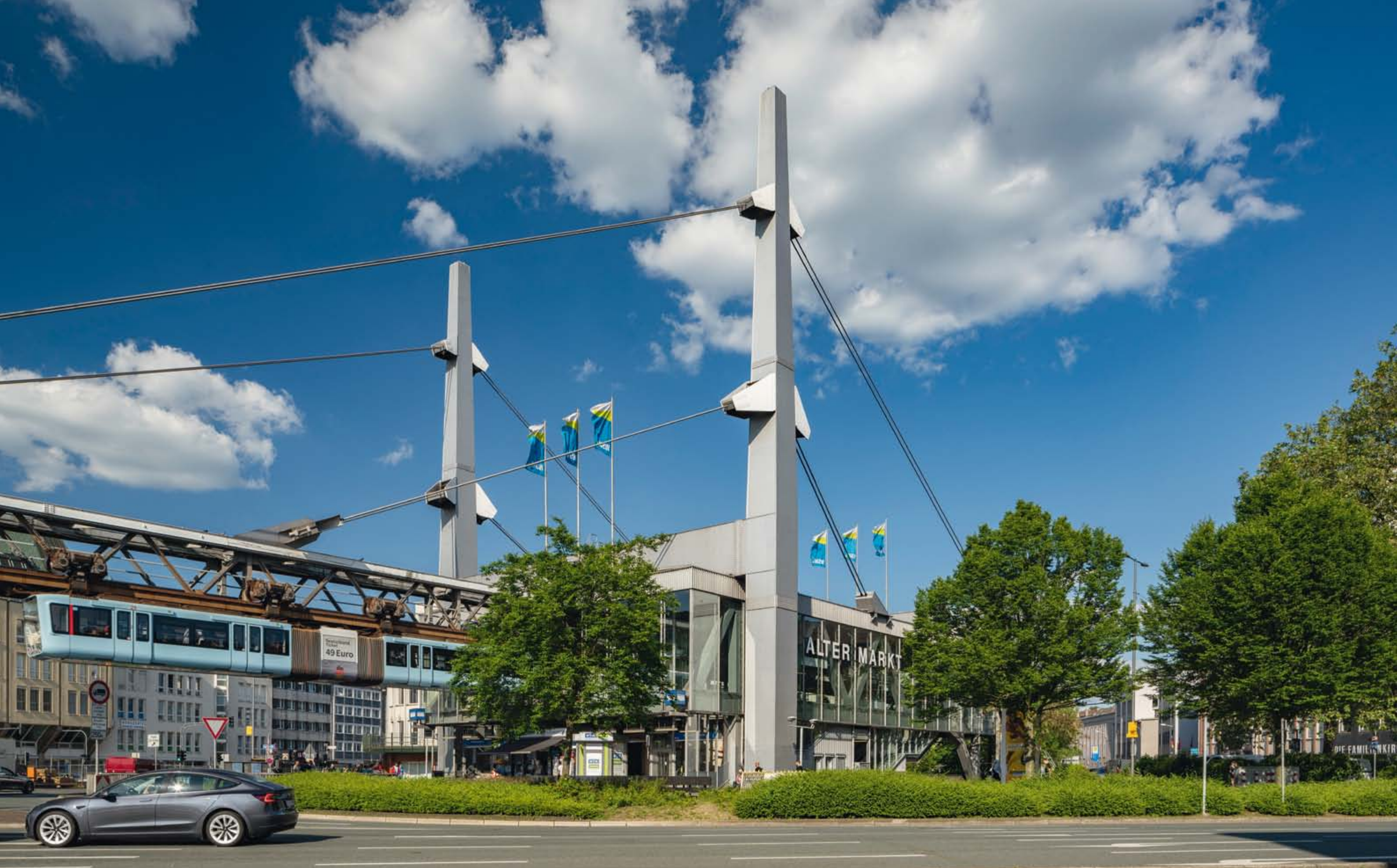
Bergisches Land - Schwebebahnstation Alter Markt in Wuppertal-Barmen © klaes-images/Holger Klaes
