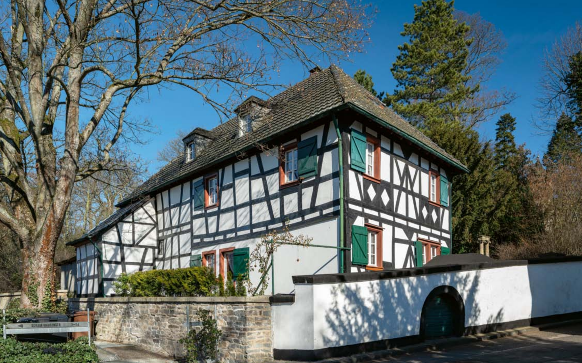
Siebengebirge - Fachwerkhaus von 1776 in der Schaaffhausenstraße in Bad Honnef-Rommersdorf © klaes-images/Holger Klaes
